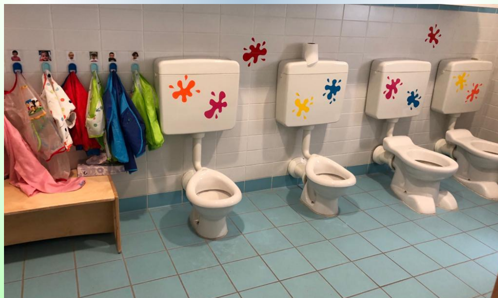
Spazi interni: bagno
